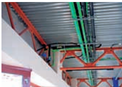
MILLENNIUM STADIUM, монтаж под крышей
