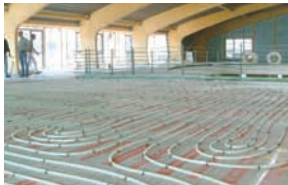
MAX-FITNESS-CENTER, укладка тёплого пола...
